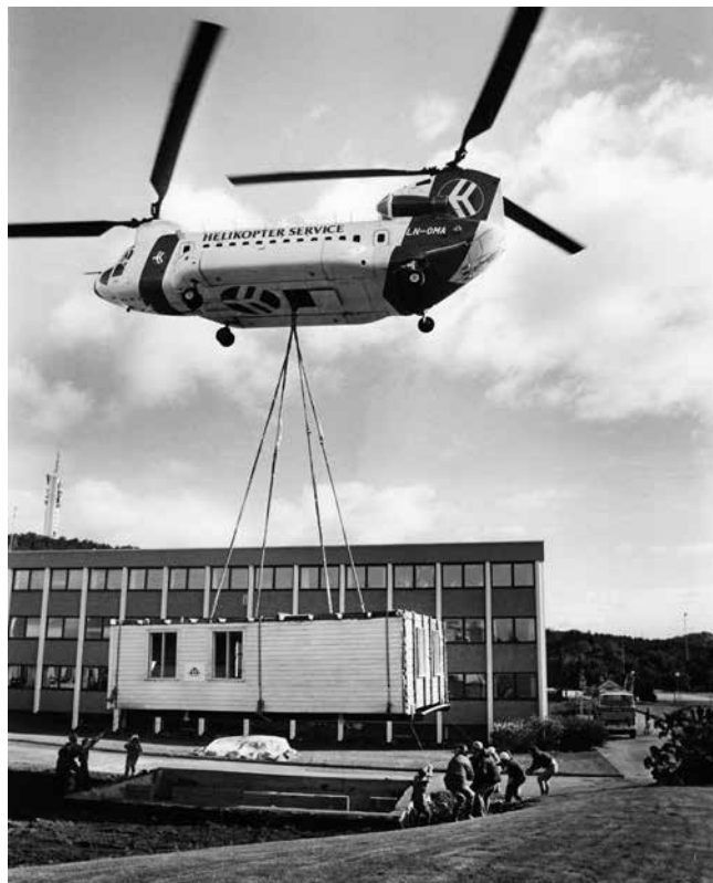
Helikopter set huset på plass på det oppførte fundamentet.
