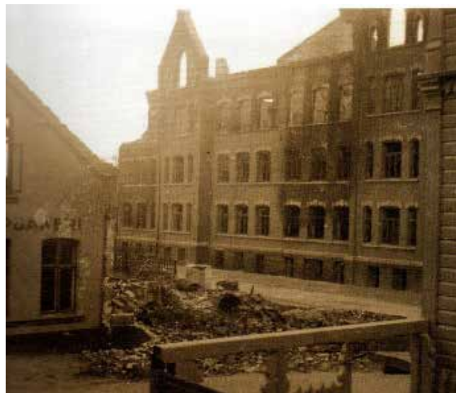
Storhaug skole kom i brann i 1940. Bare ruinene sto igjen. Den ble tatt i bruk igjen skoleåret 1949/50
