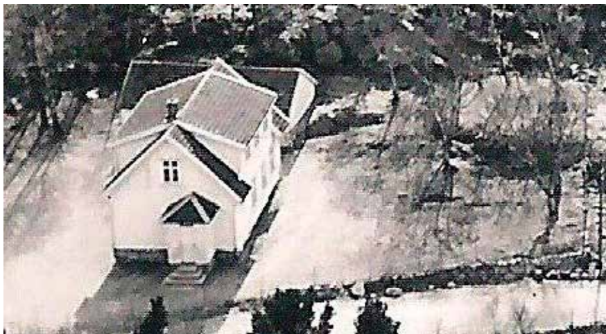
Skulehuset på Lauvås etter påbygg med sløydsal i 2.høgda 1948.
